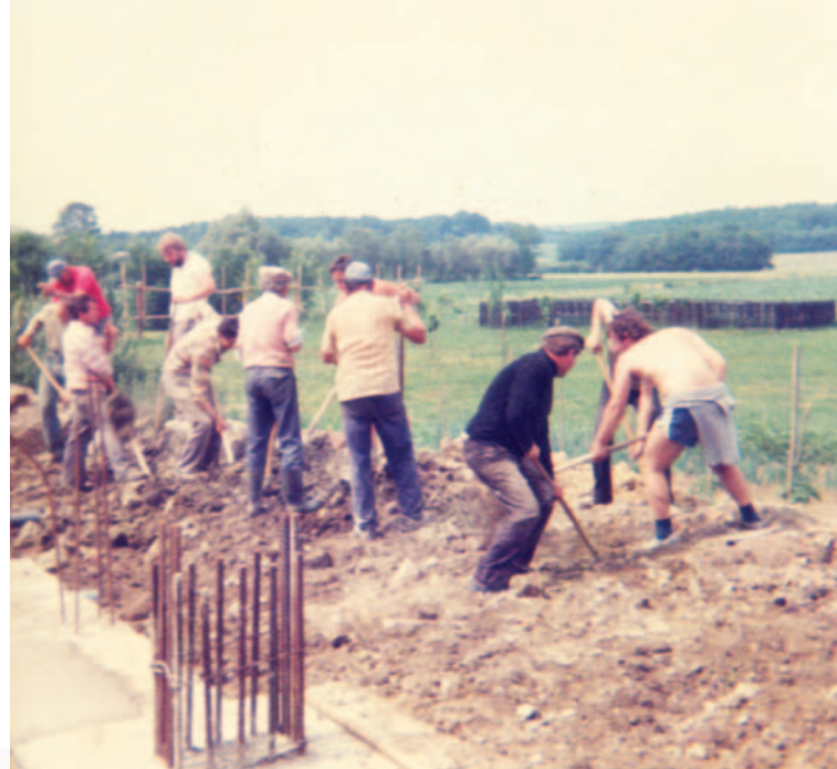
»Začetek izgradnje Vaško-gasilskega doma«.
